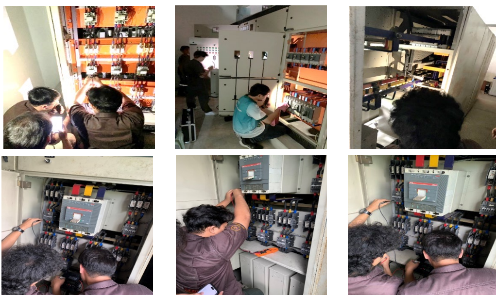
ภาพที่ 3 การตรวจวัดและเก็บค่า Capacitor Bank และเปลี่ยนอุปกรณ์ที่ชำรุดเสียหาย
