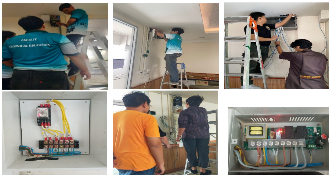
ภาพที่ 6 การติดตั้งระบบ Access Control ห้องเรียนรวม ชั้น 3 อาคาร 52
