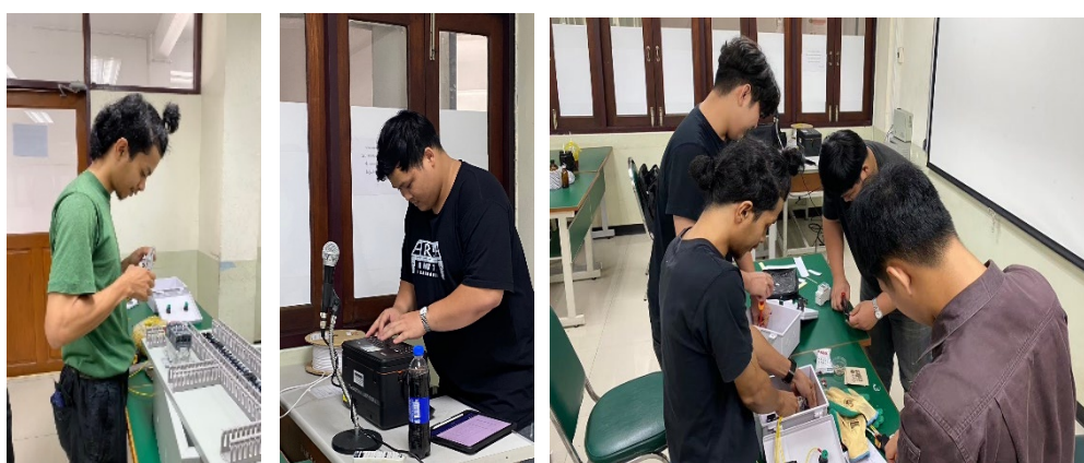
ภาพที่ 4 การประกอบตู้ควบคุมและเดินสายภายในตู้
