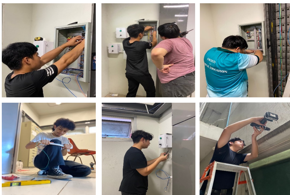
ภาพที่ 5 การติดตั้งท่อร้อยสายและติดตั้งระบบควบคุมไฟอาคาร
