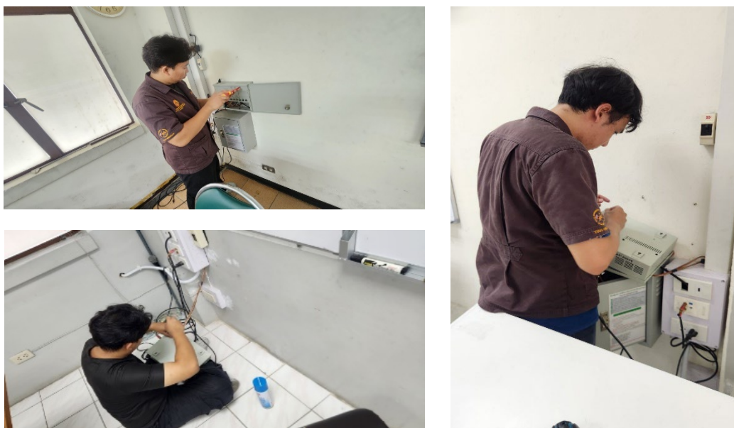
ภาพที่ 2 การบำรุงรักษาระบบเครื่องเสียง ห้องเรียนรวม อาคาร 52
